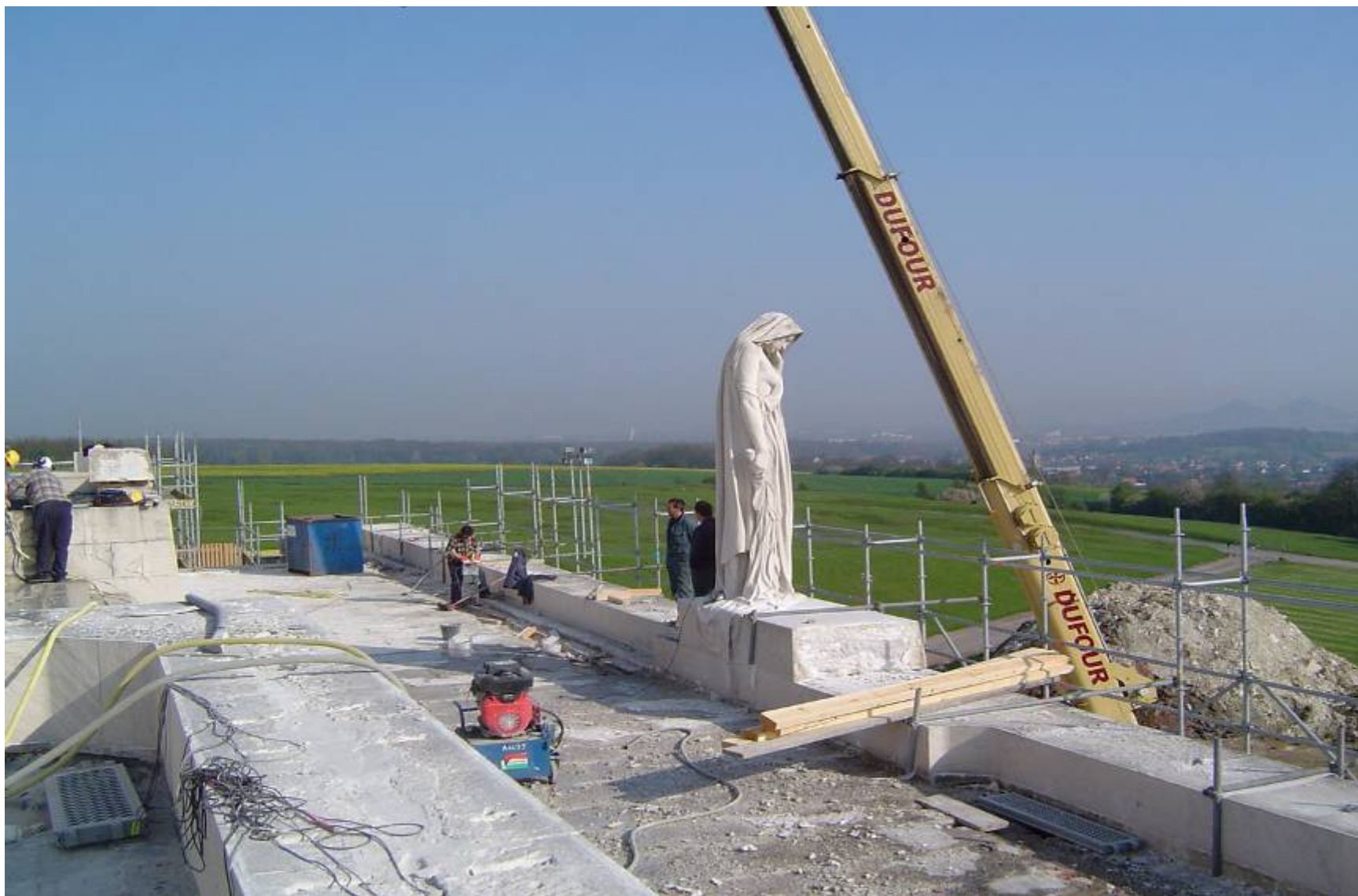
Dépose couvres-murs du mur avant.
